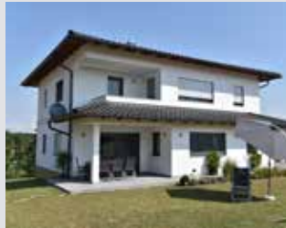
Ziegel-Rollladenkästen mit Sonnenschutz
