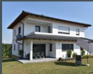
Ziegel-Rollladenkästen mit Sonnenschutz
