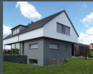
Vorbau und Unterputzkästen mit Rollläden oder Raffstore
